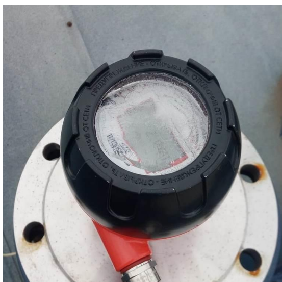
Фото 3. Лёд на стекле уровнемера
